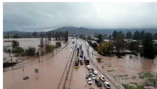
Imagen 2. Ciudad afectada por inundación.
