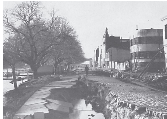
Imagen 3. Falla de tierra en las calles de Valdivia producto del terremoto de 1960.
