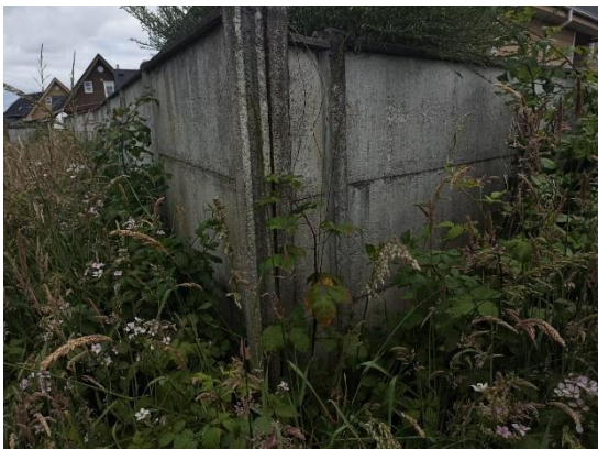
Imagen 3. Costado Este del Sector 5, delimitación del humedal con las viviendas.
